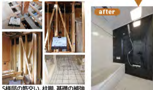
S様邸の筋交い、柱脚、基礎の補強
