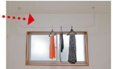
洋室には折り畳んで天井にしまえる物干しを設置しました!
