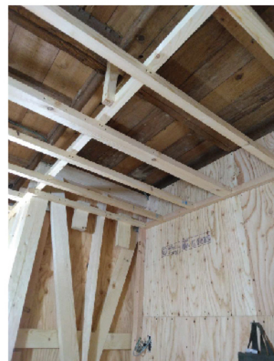
壁補強と天井下地
