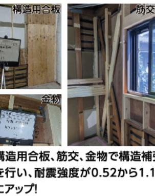
構造用合板、筋交、金物で構造補強を行い、耐震強度が0.52から1.17にアップ!
